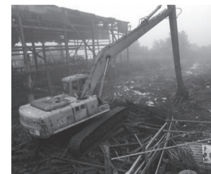
Lai Chi Vun demolition works
